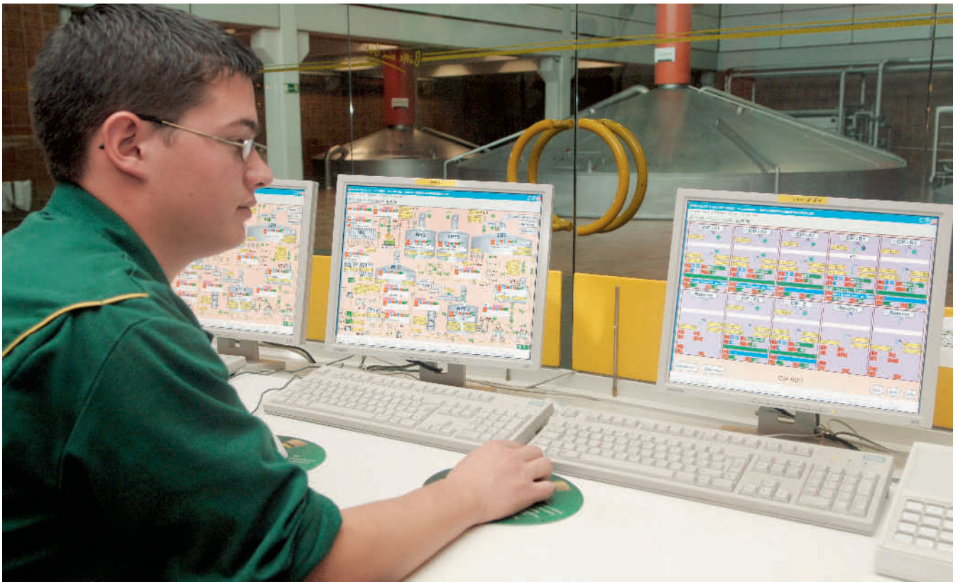
Sudhaussteuerung in einer Brauerei
